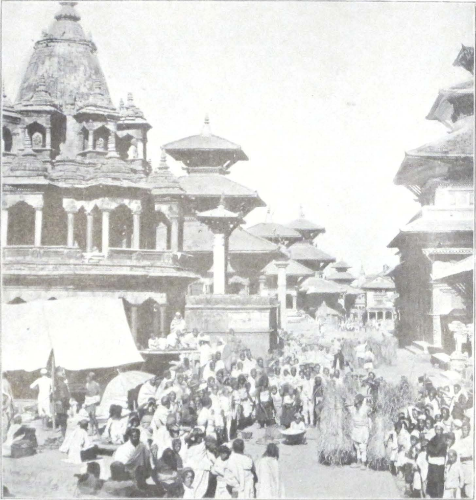
Hauptstraße in Patan. (S. 58)
